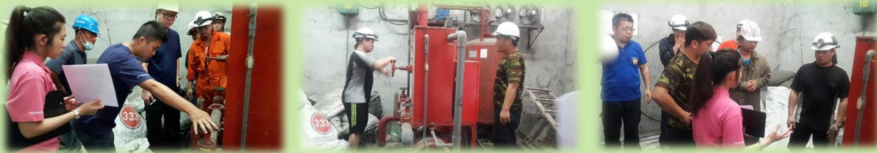
經由三點測試方法測試幫浦效能，確保火災發生時幫浦得以發揮其正常效能。
